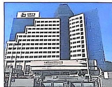
中石化安庆石化公司项目
