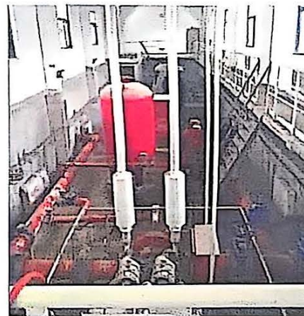
华润电力沈阳电厂项目
