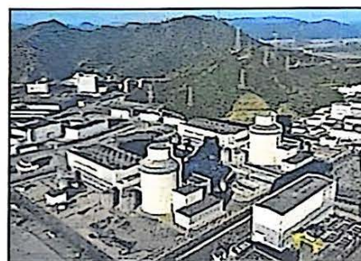
三门核电二期项目
