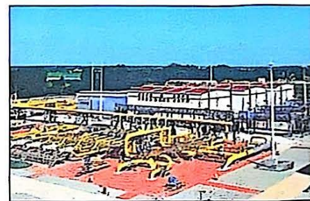
陕京四线输气管道站项目
