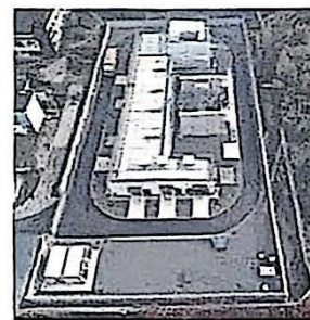
衢州城北110kv变电站
