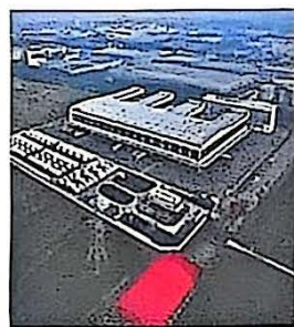
泰州海陵储能电站
