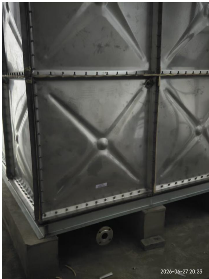
板缝螺栓与密封连接
